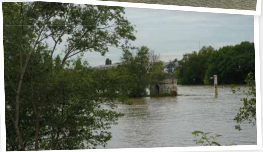
La SHN souhaiterait que ce petit édicule, dernier témoin du barrage à aiguilles, soit conservé et restauré.
