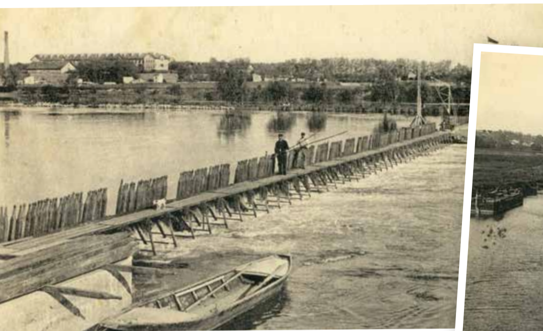
Le barrage à aiguilles avec, en arrière-plan, les bâtiments de la Maison de Nanterre, devenue le Cash.
