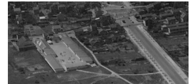
Avant d'être Joliot-Curie, le lycée de Nanterre fut une annexe du lycée (parisien) Condorcet Photo : IGN Remonter le temps
