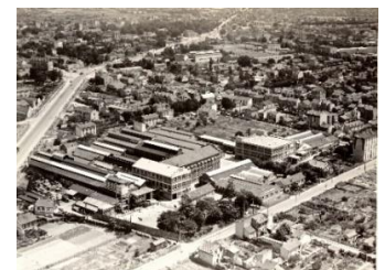
Vue aérienne de 1956 « Remonter le temps »
