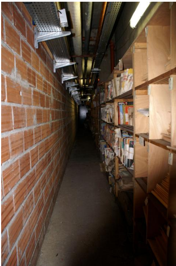
Couloir des archives
